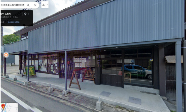
図1 地域拠点開設物件(外観)
